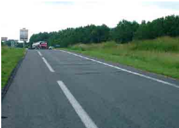
Bandes rugueuses placées sur une zone de freinage
