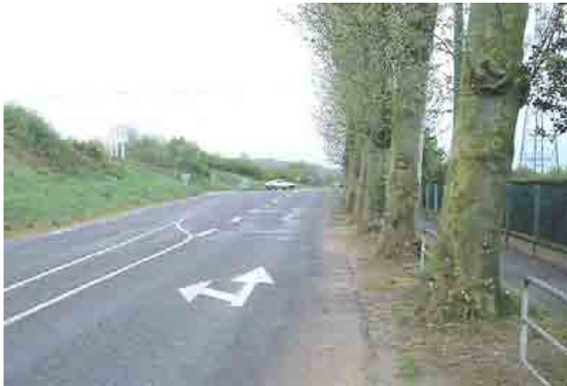
Obstacles (arbres et rochers) situés en bordure de route pouvant aggraver le bilan lésionnel d'un conducteur de deux-roues en glissade
