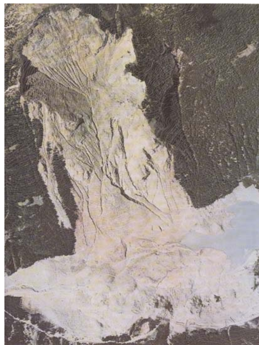
Figure 17: Vue aérienne du versant du Mont Zandila après la catastrophe
