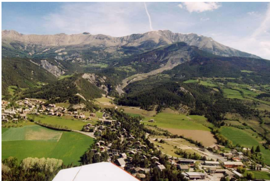
Figure 20: Vue aérienne du glissement-coulée de La Valette (au premier plan le cône de déjection du torrent, à l'arrière plan le contact tectonique marnes du Callovo-Oxfordien / nappes de l'Embrunais)
