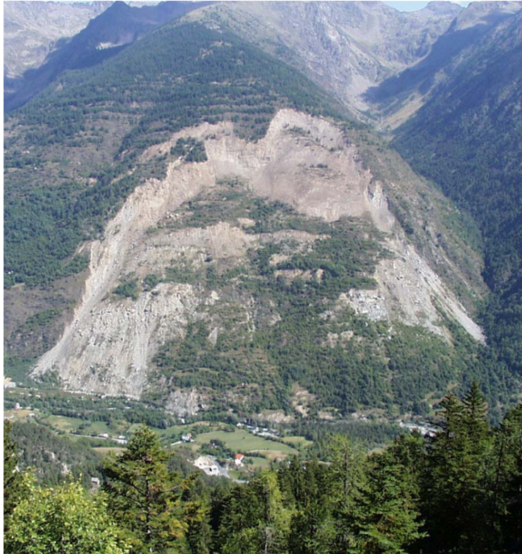
Figure 31: Vue d'ensemble du glissement en 2000
