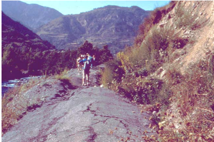
Figure 26: Déplacement de la base du versant vers la Tinée et déformation de l'ancienne route départementale en 1989
