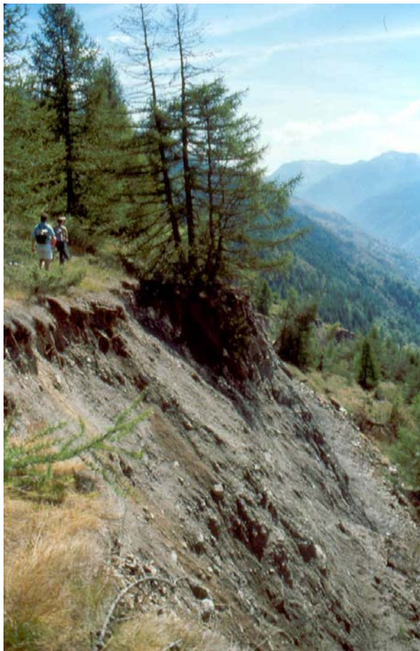
Figure 27: Vue d'une partie de l'escarpement supérieur en 1989
