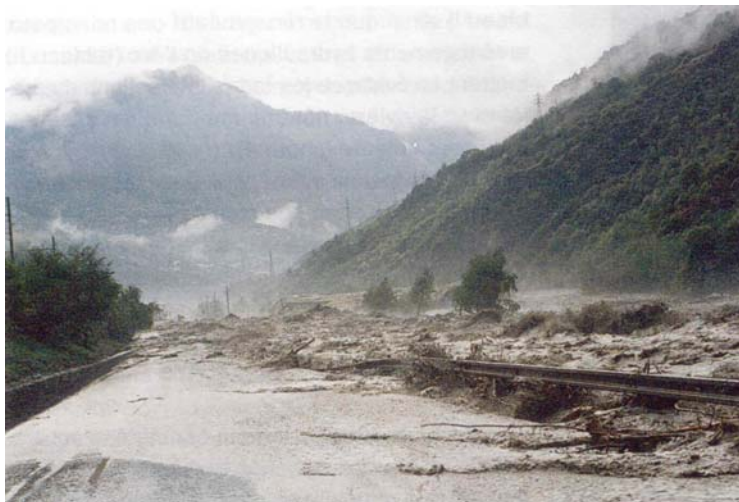
Figure 5: Le torrent du Pousset, alluvionnant à la confluence avec l'Arc, lui-même en crue, provoque l'envahissement de la chaussée de la route nationale N6 et l'érosion des rives opposées.
