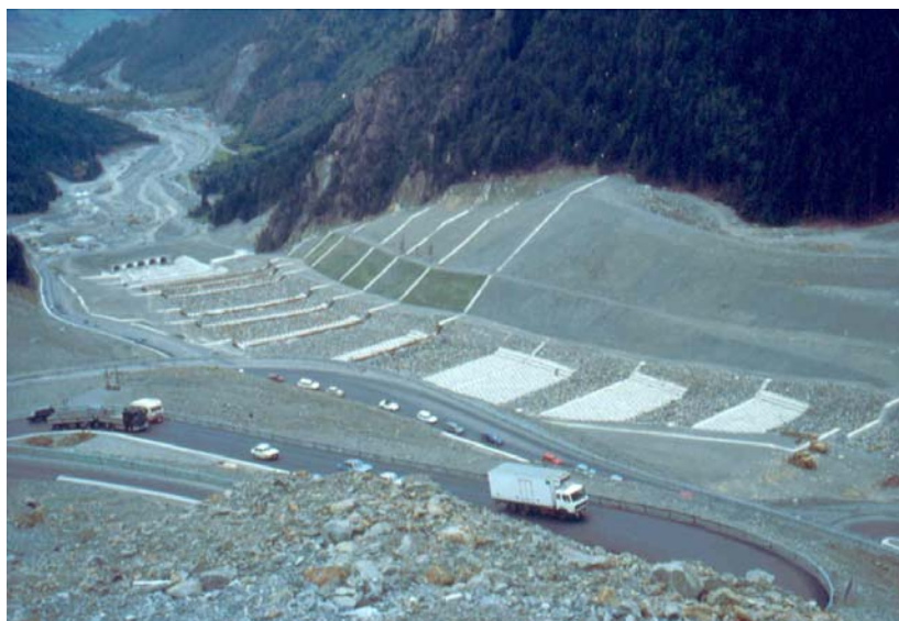
Figure 19: Travaux de remodelage du cours de l'Adda (vue vers l'aval)
