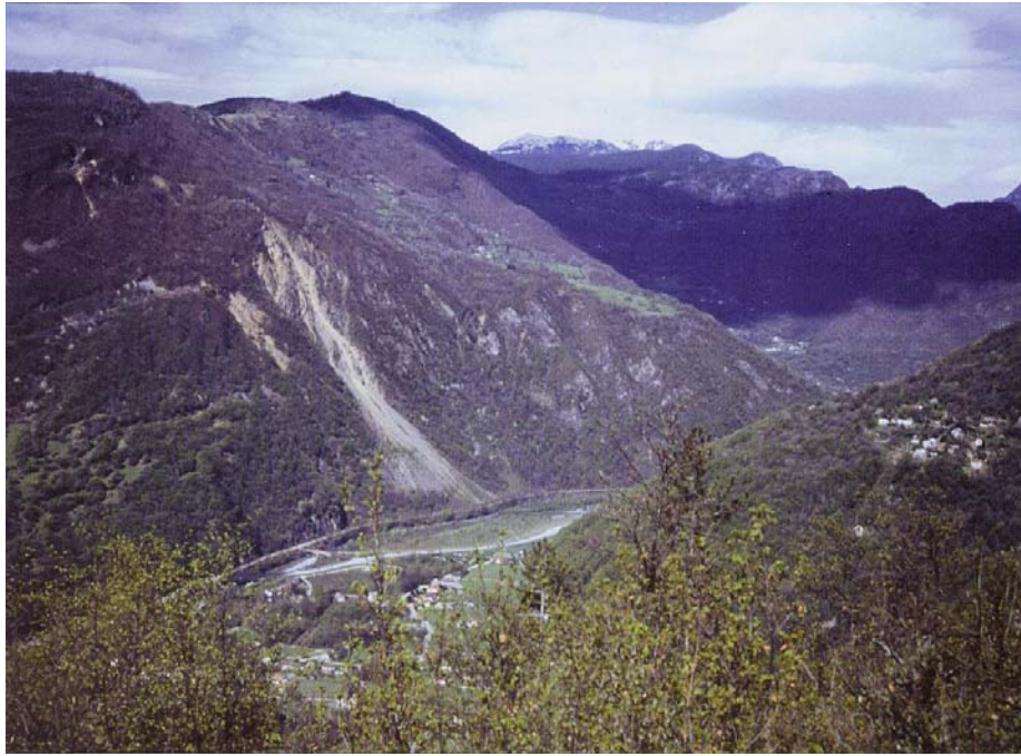
Figure 32: Vue d'ensemble du versant instable de Séchilienne, avec au premier plan l'Ile Falcon et la déviation de la route nationale N91. La cicatrice verticale des « Ruines de Séchilienne » limite à l'est la zone instable.
