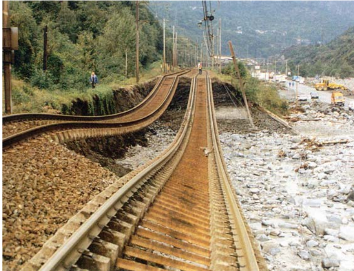
Figure 6: Dommages sur la route nationale N6 et la voie ferrée Paris-Turin, après la crue de l'Arc et l'activité torrentielle du Pousset en octobre 1994.
