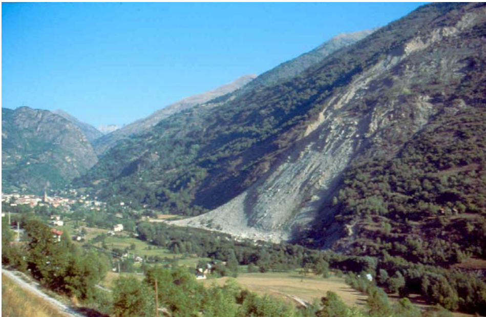
Figure 30: Vue d'ensemble du glissement en septembre 1989, le village de Saint-Etienne-de-Tinée à gauche, en amont
