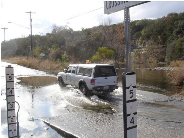
Photo 5 : Échelles graduées disposées au niveau d'un passage à gué, Austin, Texas. Crédit photographique : I. Ruin, 2006.
