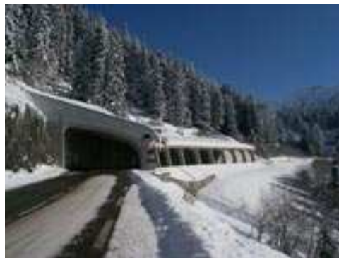
FIG. 5.1 – Photo de la galerie paravalanche de Flaine - Haute Savoie (source www.beton-haute-savoie.com )
