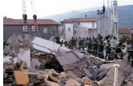
Les décombres de l'école de San Giuliano di Puglia à la suite du séisme de Molise. ©Dipartimento della Protezione Civile, 2002.
